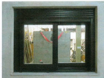
Figura 2 – Vista externa da esquadria instalada
