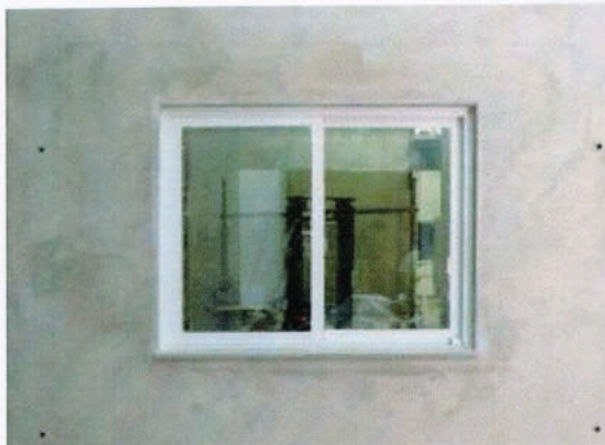
Figura 1 – Vista externa da esquadria instalada
