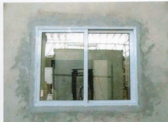
Figura 2 – Vista interna da esquadria instalada
