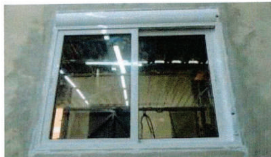
Figura 1 – Vista interna da esquadria instalada
