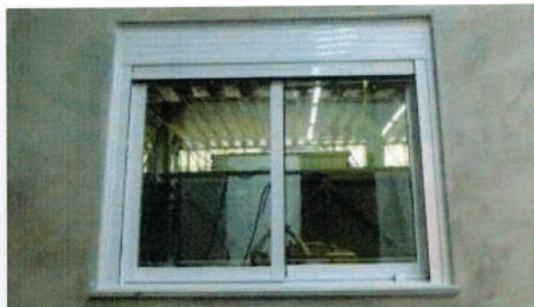
Figura 2 – Vista externa da esquadria instalada
