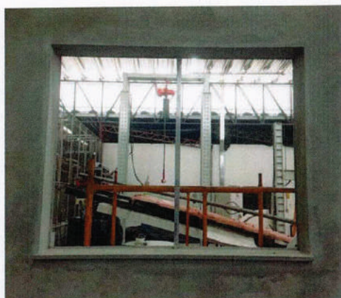
Figura 1 – Instalação da esquadria
