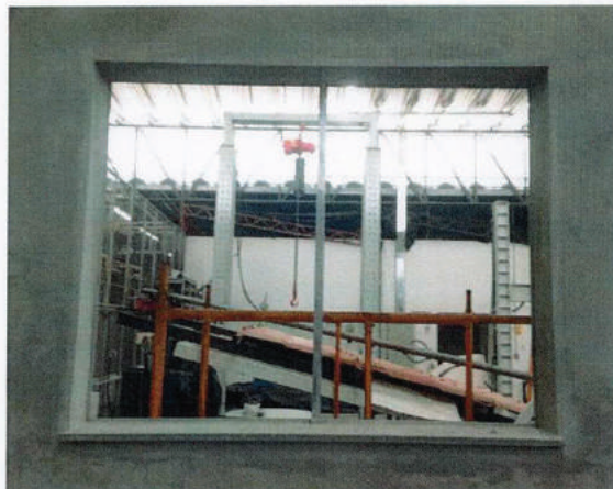
Figura 1 – Instalação da esquadria
