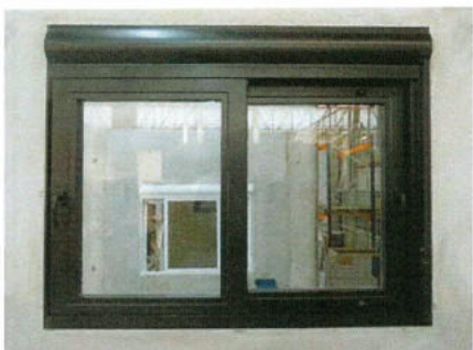
Figura 1 – Vista interna da esquadria instalada
